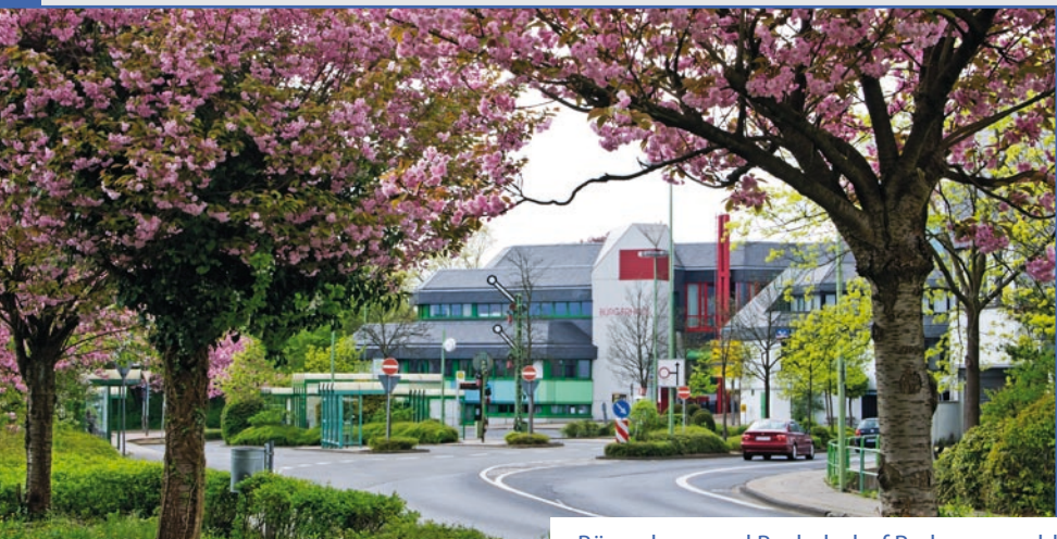
Bürgerhaus und Busbahnhof Radevormwald
